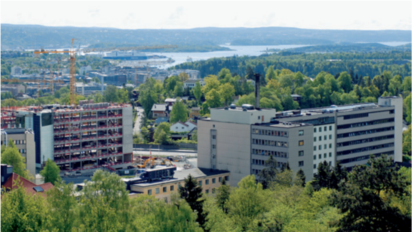
Radiumhospitalet har i løpet av sin 75 år lange historie utviklet seg til å bli et avansert kreftsykehus i internasjonal klasse. Nybygget til venstre skal etter hvert huse forskningsavdelingen. Foto Per Løchen/SCANPIX
